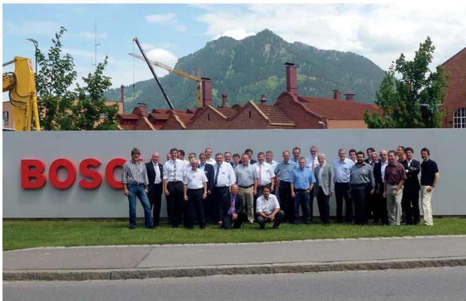
Rund 40 Teilnehmer waren zum AGI-Regionalkreis Süd bei Bosch in Blaichach gekommen. Bagger und Baukran weisen schon auf die weitreichenden Baumaßnahmen am Standort hin. So werden die Ziegelgebäude in Kürze abgerissen, die darin befindlichen Produktionsflächen in andere Gebäude verlagert. Gleichzeitig entsteht bereits eine neue Energiezentrale.
