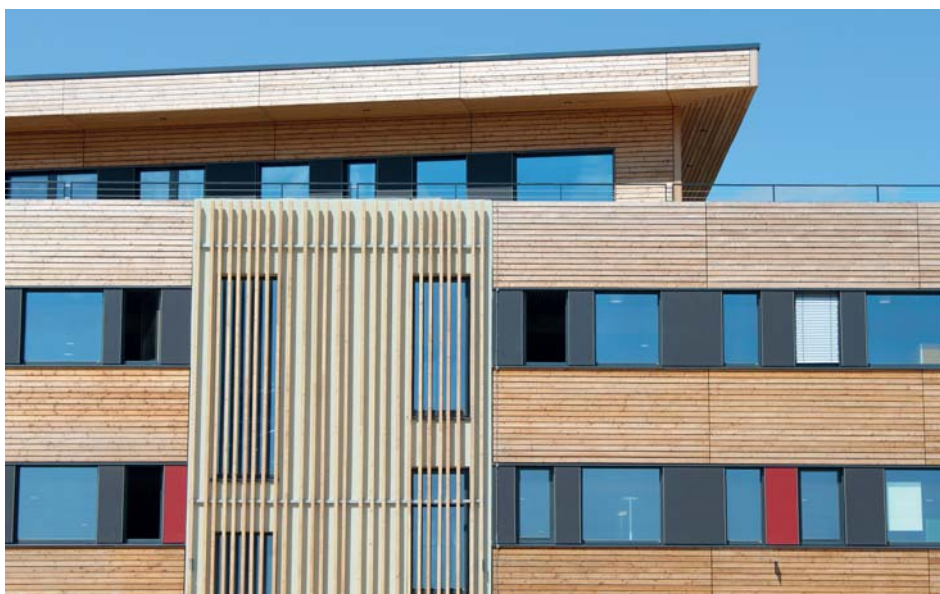
Der Holzskelettbau besticht durch sein zurückhaltendes Äußeres.
