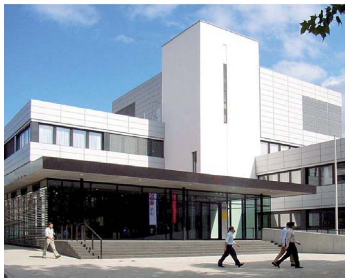
Sanierung von Fe 412/413.
