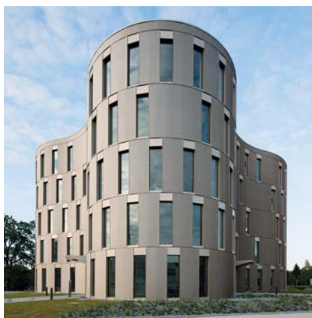
Durch die variierende Positionierung der Fensteröffnungen wirkt die Fassade spielerisch.
