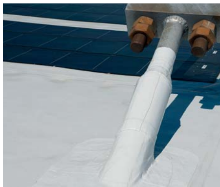
Neben der Verlegung der dachintegrierten PV-Anlage ergaben sich weitere Details, die fachtechnisch zu lösen waren. Hierzu zählen die dauerhaft funktionssichere Einbindung aller Stützpfeiler und Abspannanker der Tragkonstruktion.
