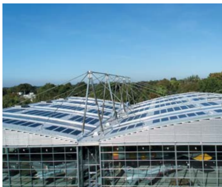
Dauerhafte Teilverschattungen durch die über die Dachfläche herausragenden Bauteile der Tragkonstruktion des Daches lassen sich nicht vermeiden. Trotzdem sollen sich die Kosten der PV-Anlage rasch amortisieren.
